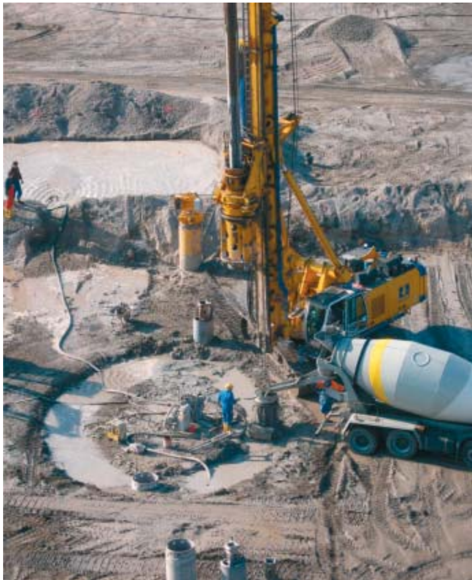
RIESIGE RAMMEN schlagen Tausende Löcher, damit Pfähle für die notwendige Gründung sorgen konnten.
